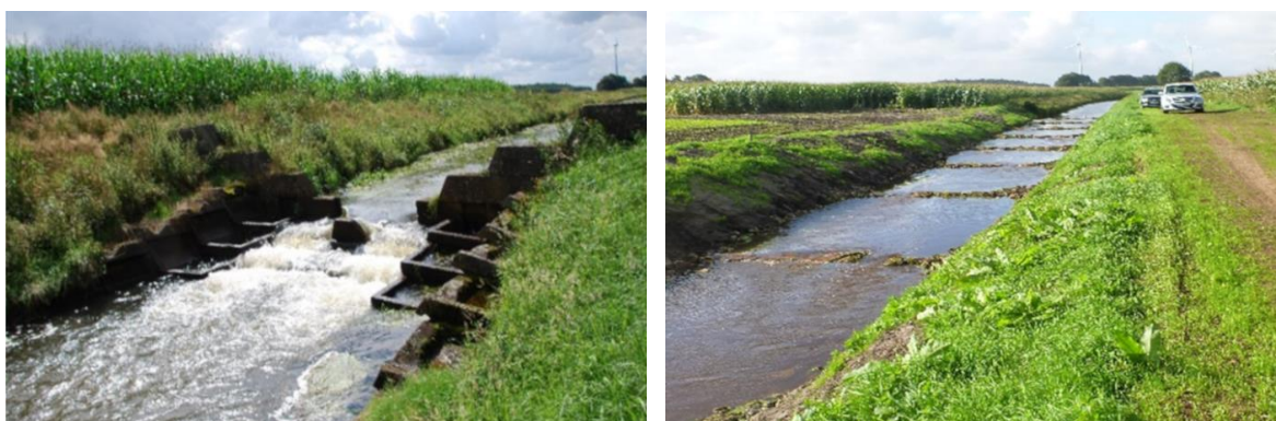
Abb. 13: Herstellung der Durchgängigkeit an der Ohe. Links: Vorhandener Kaskadenabsturz, rechts: Sohlgleite nach Abschluss der Bauarbeiten (Quelle: NLWKN)
