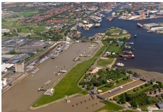
Abb. 27: Emdener Außenhafen Schleusen trennen das schwebstoffhaltige Wasser und das Binnenwasser des Hafens (Quelle: Niedersachsen Ports)
