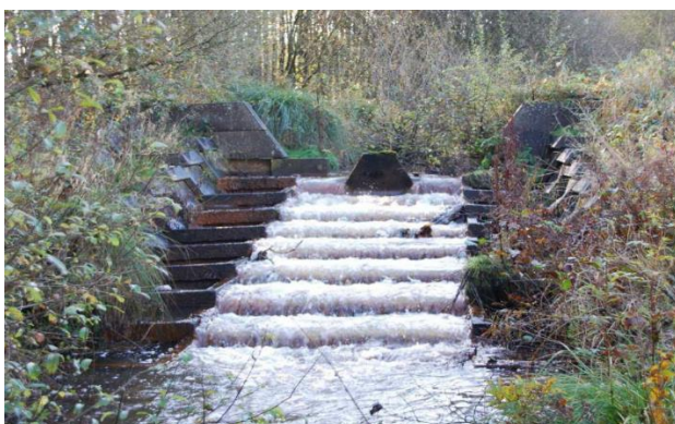
Afbeelding 10: Realisering van de passeerbaarheid in de Ohe. Links: verwijderde cascadetrap, rechts: vistrap van keien na voltooiing van de werkzaamheden (Bron: NLWKN)
