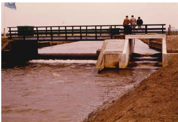
Afbeelding 9: Verbetering van de vispasseerbaarheid bij de stuw Gieterveen op de Hunze (provincie Drenthe) door aanleg van een bypass. Links: stuw Gieterveen met oude vistrap uit 1986, rechts: voor de bypass is een oude meander gereactiveerd (Bron: Waterschap Hunze en Aa's)
