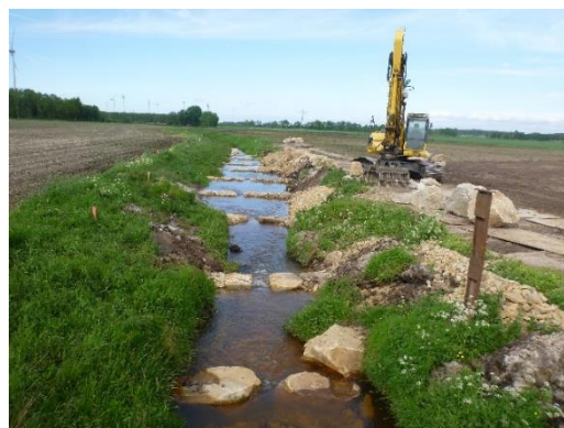
Afbeelding 10: Realisering van de passeerbaarheid in de Ohe. Links: verwijderde cascadetrap, rechts: vistrap van keien na voltooiing van de werkzaamheden (Bron: NLWKN)
