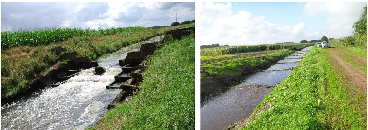
Abbildung 10: Herstellung der Durchgängigkeit an der Ohe. Links: Beseitigter Kaskadenabsturz, rechts: Sohlgleite nach Abschluss der Bauarbeiten (Quelle: NLWKN)
