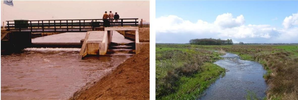
Abbildung 9: Verbesserung der Fischdurchgängigkeit am Wehr Gieterveen an der Hunze (Provinz Drenthe) durch Schaffung eines Umgehungsgerinnes. Links: Wehr Gieterveen mit alter Fischtreppe aus dem Jahr 1986, rechts: Für das Umgehungsgerinne wurde eine alte Gewässerschleife reaktiviert (Quelle: Waterschap Hunze en Aa's)
