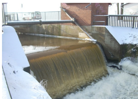
Schützenhof-stuw vóór de verbouwing...
