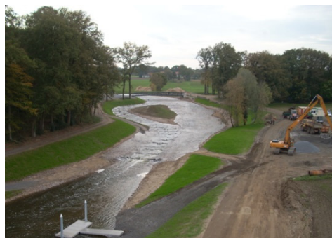
... en na de verbouwing
