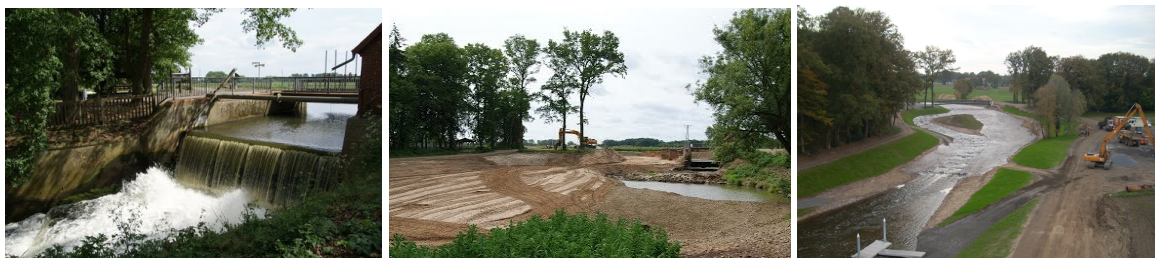
Abbildung 9: Umbau des Schützenhofwehres Quakenbrück in eine Sohlengleite: Wehr vor dem Umbau (links), während der Bauphase (Mitte) und nach dem Umbau (rechts) (Quelle: NLWKN)
