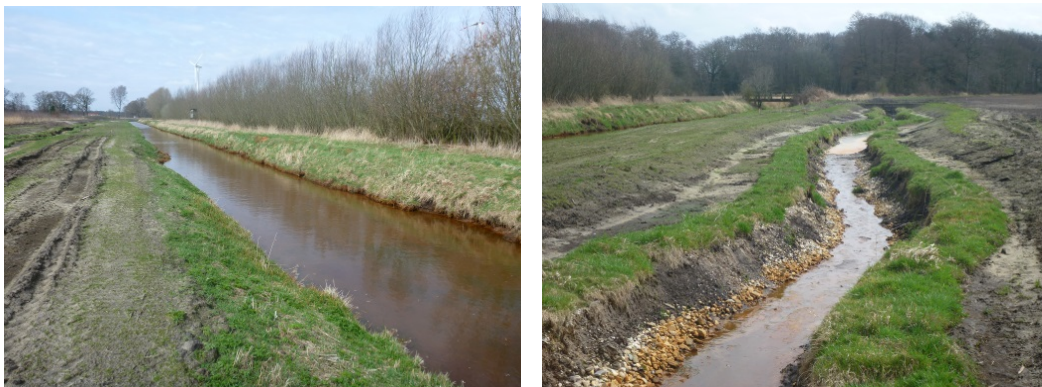
Abbildung 6: Bau eines naturnahen Nebengerinnes entlang der Melstruper Beeke bei Lathen im Landkreis Emsland (links: altes Gewässerbett, das für den Hochwasserabfluss erhalten bleibt; rechts: Nebengerinne kurz nach Abschluss der Baumaßnahme) (Quelle: NLWKN)
